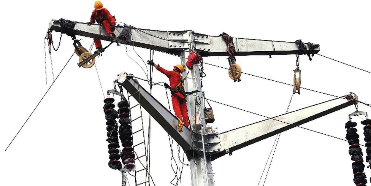
8月15日,在干江镇小屿门工业园区旁,国家电网电力施工人员正在铁塔和钢管塔上安装绝缘子串,为新建110千伏变电站架线作准备。
