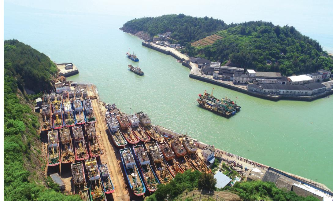
东海伏休后，我市广大渔民抓紧进行“三修（修渔船、修网具、修机械）”工作。在玉环市灯塔船舶修造厂，工人们正忙着对船台上的30多艘渔船进行切割、焊接、漆刷等维修保养。
