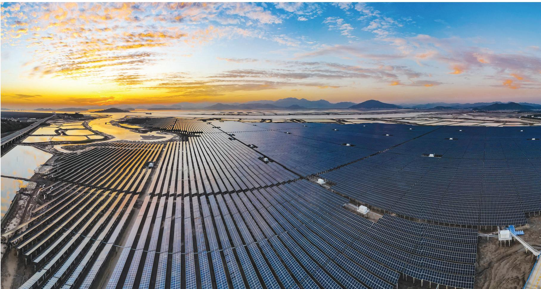
近年来，我市积极践行生态优先、绿色发展理念，大力发展战略性新兴产业，利用自身海域滩涂优势，成功在120万平方米滩涂上安装24.2万片光伏组件，实现年发电量1.5亿千瓦时，可每年节约标煤约4.5万吨，减排二氧化碳11万吨以上。图为华能清港100MW滩涂渔光互补光伏电站项目在夕阳照射下熠熠生辉，源源不断向外输送清洁绿电。
